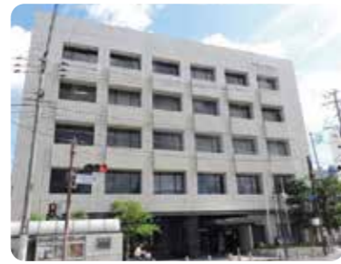
唐津商工会館全景
